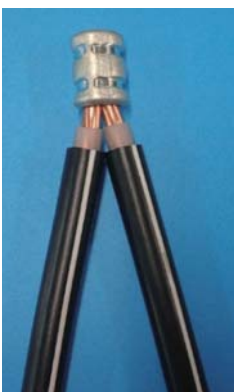
① ケーブルを段剥ぎし、導体を接続します。
