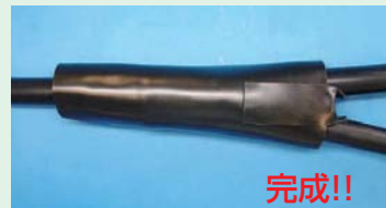
6 分岐線部に粘着カバー巻き
