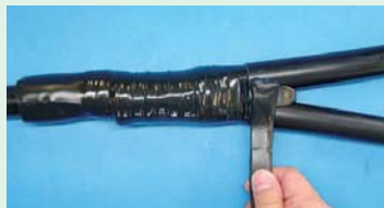
4 絶縁テープ巻き及び 防水パテにて谷埋め
