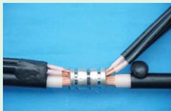
2 防水パテを各線心間に埋める
