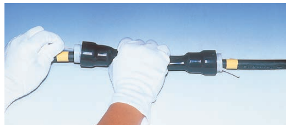
⑤マーキング部にブルフィットチューブを合わせ、コア紐を引き抜きます。
