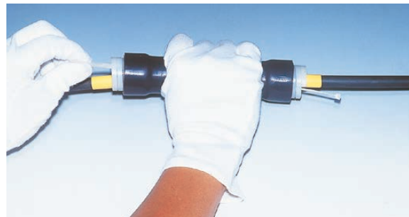
⑥チューブ中央部をしっかりと押さえながら、コア紐を引き抜きます。
