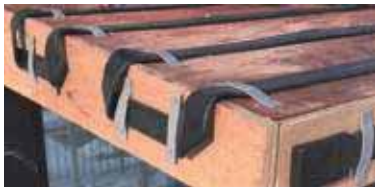
北海道の融雪工事現場
